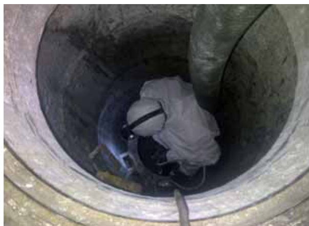
Rys. 19. Czyszczenie zbiornika podziemnego
