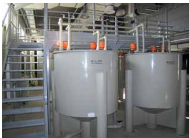
Rys. 3. Hala Odzysku – instalacja do odzysku soli metali
