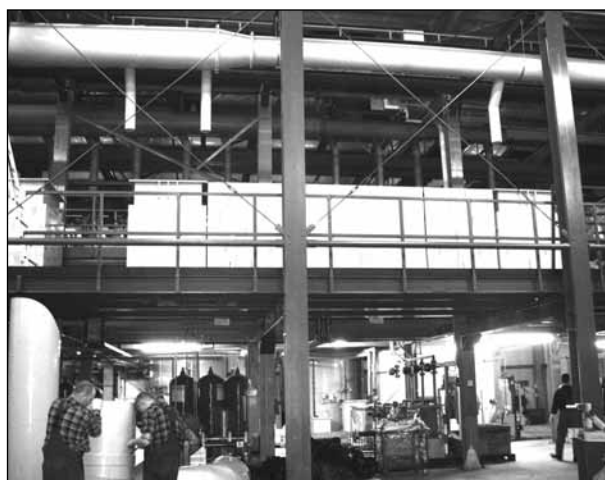
Ryc. 3. Linia automatyczna do impregnacji dla Heiche zlokalizowana na Węgrzech- rok 2009. Linia dwurzędowa w układzie pionowym.
